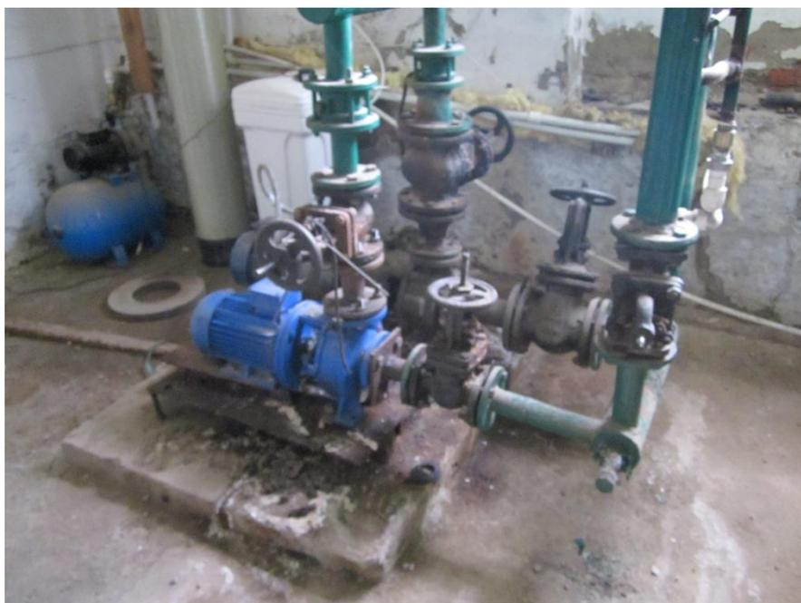
Рисунок *Насосный узел Центральной котельной.*
