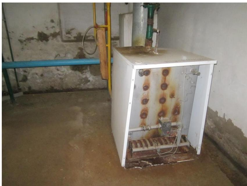
Рисунок Котлы ИШМА 100, обеспечивающие теплоснабжение от центральной котельной. В котельной, расположены: 2 – рабочих и 2 – резервных котла общей мощностью.
