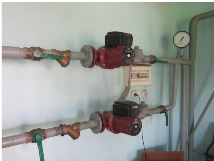
Рисунок *Насосы GRUNDFOS UPS 32-120 F 230V, обеспечивающие циркуляцию в системе теплоснабжения МБОУ СШ №23, посёлок Трёхречный.*
